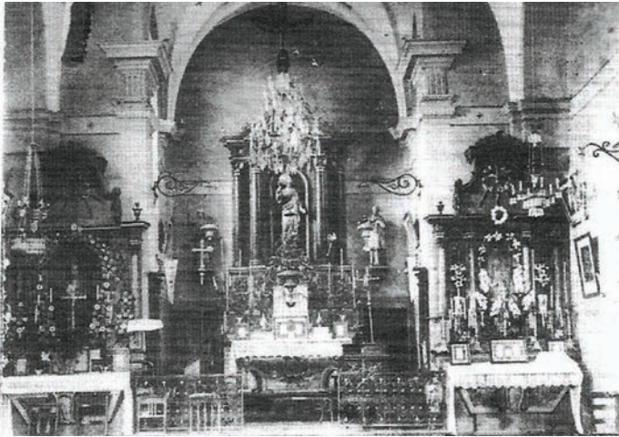
À noter: la table de communion et les Autels latéraux. Sur le côté gauche il y avait un trou pour le tuyau de fumée
