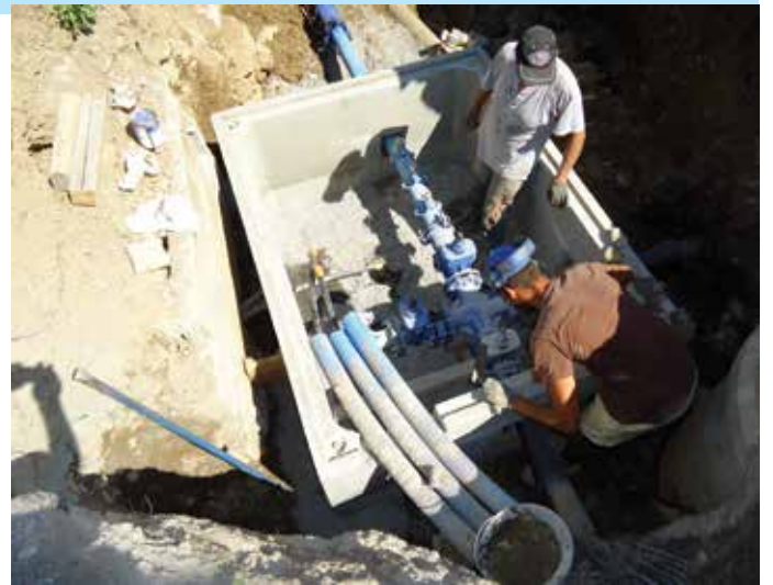
Remise en état d'une chambre à vannes route Vers le Nant. Ces travaux s'inscrivent dans un programme d'entretien du réseau d'adduction d'eau potable. Le poteau incendie associé a également été changé.
