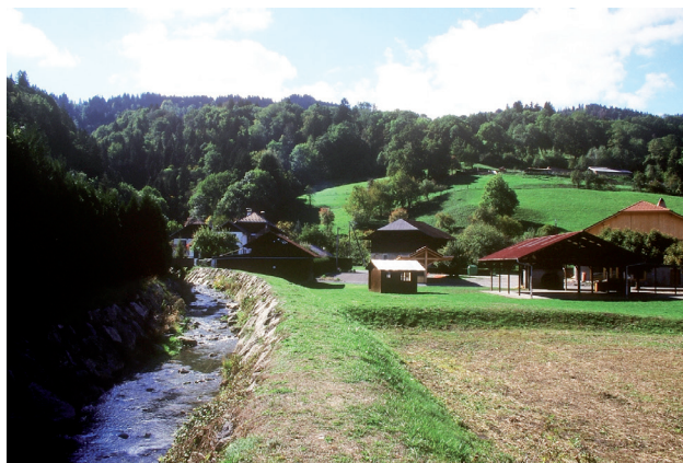
Le ruisseau d'Arbon et ses digues de protection
